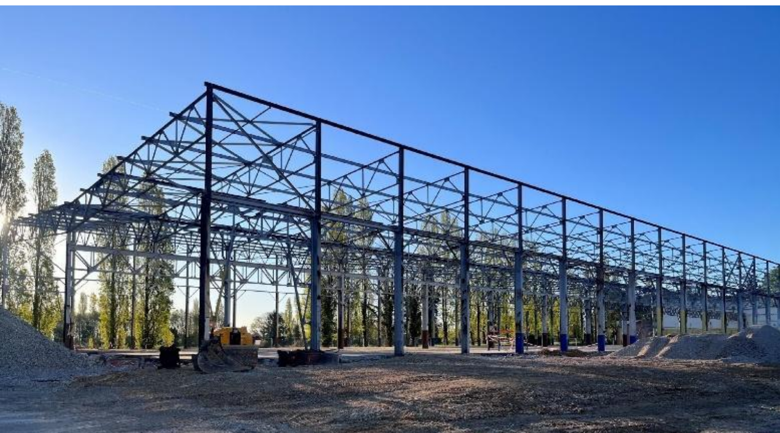
Désossage du bâtiment de la SATAM – ancien site industriel – Falaise (14) - 2026
