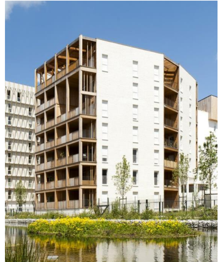
Ecoquartier Ginko, Bordeaux La Nouvelle Agence
