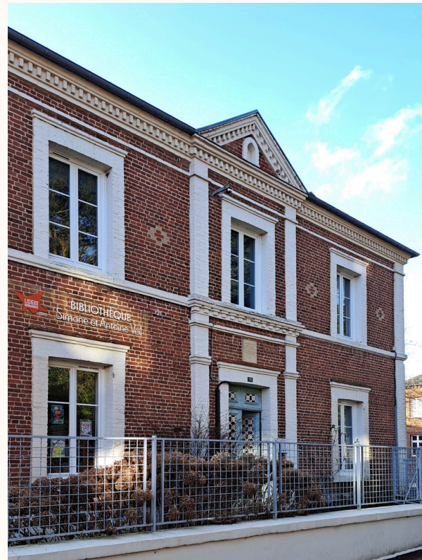
Restructuration de la médiathèque de Cambremer (14) Aro architecture + C. Coderch
