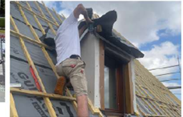
Traitement de la lucarne
