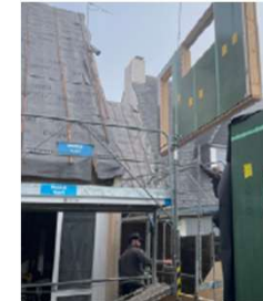
Levage des panneaux de façade : le Mesnil Patry et Agneaux
