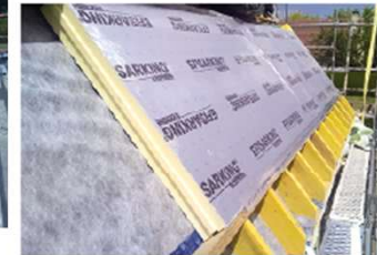
Pose du deuxième isolant thermique
