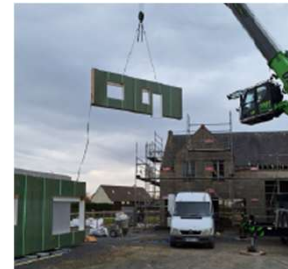
Levage des panneaux de façade : le Mesnil Patry et Agneaux
