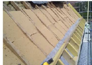
Pose du premier isolant thermique
