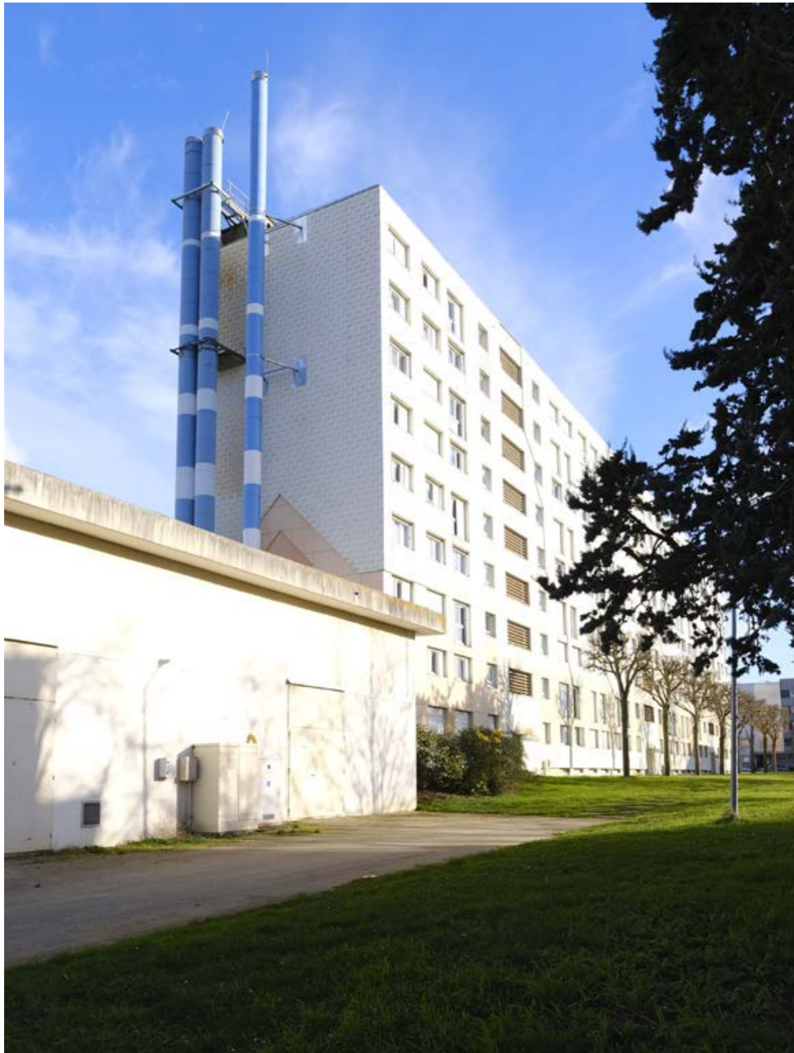
Le bâtiment existant
