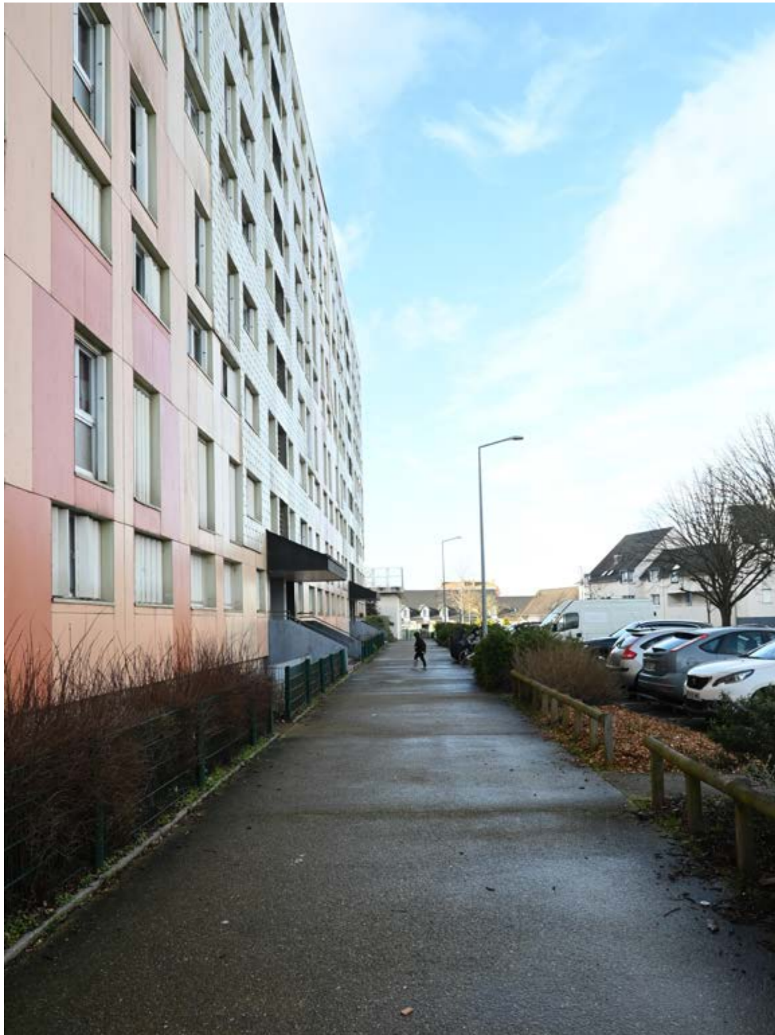
Le bâtiment existant
