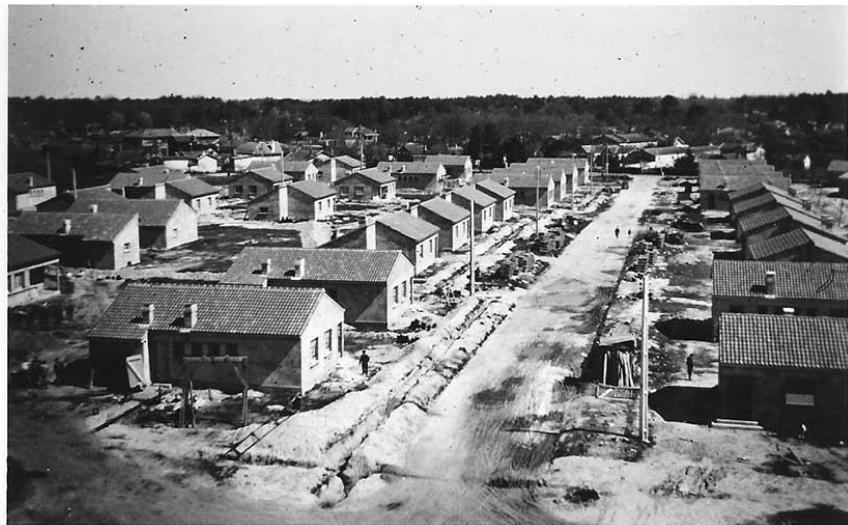
Chantier en 1950. © Association culturelle des Castors de Pessac 150 familles logées en 2 ans
