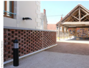
Le garde-corps est en briques de réemploi issues du site; l'ancien préau de l'école a été conservé.
